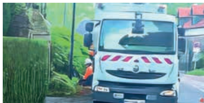
Rénovation extérieure et intérieure de l'Espace Porto-Riche 21 789,02 € TTC
